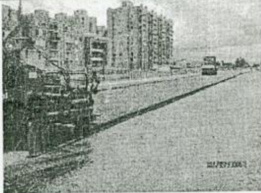
Se evidencia la instalación de carpeta asfáltica en el tramo 5
